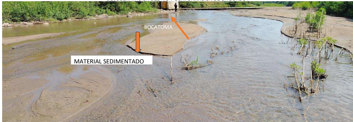
FIGURA N° 2: SE OBSERVA QUE EN EL RIO CHARANAL EN LA MARGEN IZQUIERDA HA PERDIDO TALUD O SE HA SOCAVADO, POR LO QUE ES NECESARIA LA DESCOLMATACION DEL RIO Y CONFORMACION DE UN BORDO .
